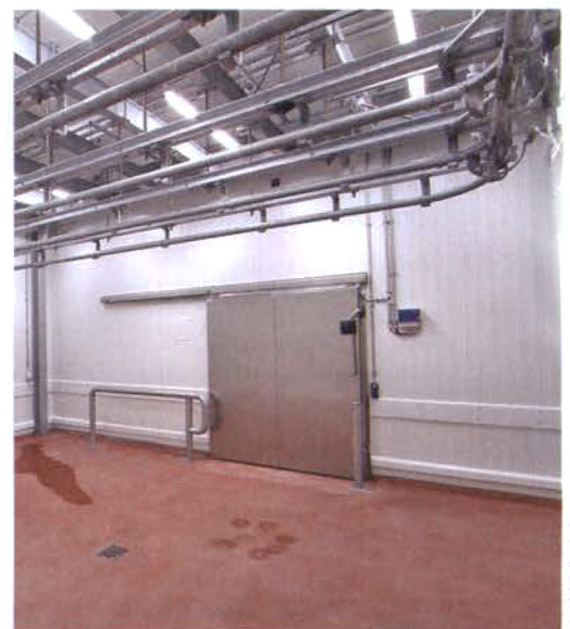
Für die Zwischenlagerung der Teilstücke von Rindern beziehungsweise Großvieh steht in dem Neubau ein eigener Kühlraum mit Sonderhöhe zur Verfügung.
